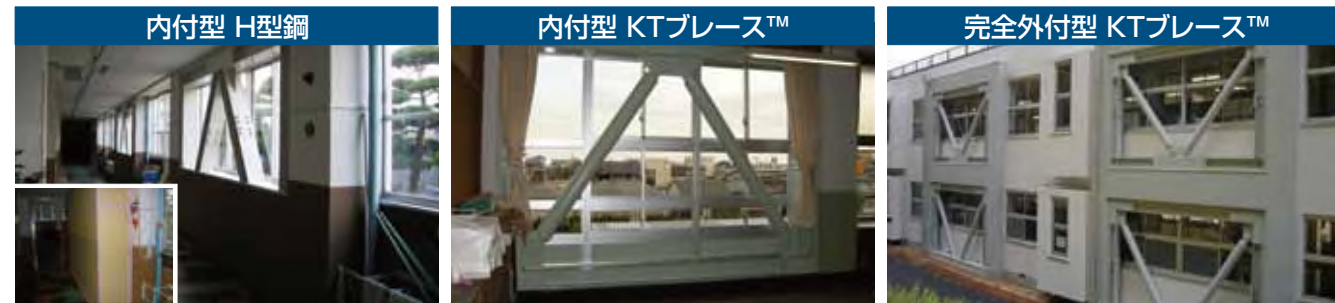
▲ 施工風景 (内部は使用しながら施工)
